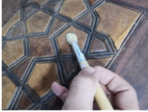
الصورة (١٨) توضح التنظيف الميكانيكي بواسطة فرشاة ناعمة
